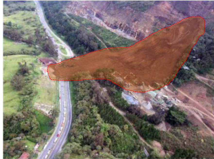
Deslizamiento de tierra en la autopista de Medellín-Bogotá, Colombia, durante octubre del 2016. Fotografía: Ingeniería Civil Free.
